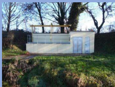
FOTO 1 IMPIANTO DI SOLLEVAMENTO
