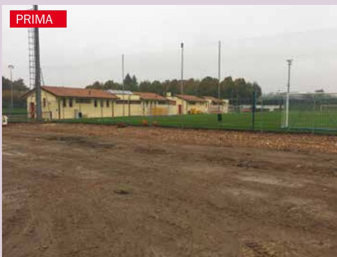
Parcheggio via Resegone - fase lavorativa
